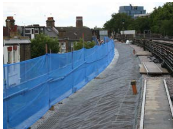
Stabilisering av banken längs en 200 m lång sträckning av tunnelbanelinjen Acton Town–Chiswick Park.
