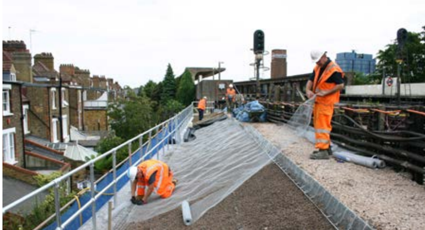
Stabilisering av banken längs en 200 m lång sträckning av tunnelbanelinjen Acton Town–Chiswick Park.
