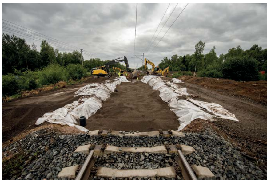
Järnvägsspåret mellan Kumo och Raumo i Finland reparerades med Leca Lättklinker som fyllnadsmaterial.
