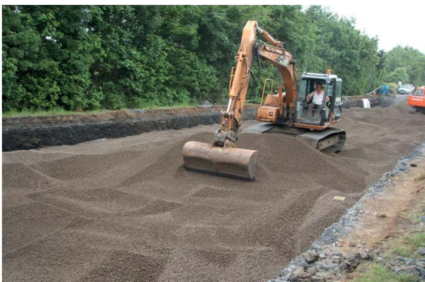
Leca Lättklinkers styrka och packningsegenskaper gjorde det möjligt att fortsätta utläggningen med hjälp av tunga fordon.
