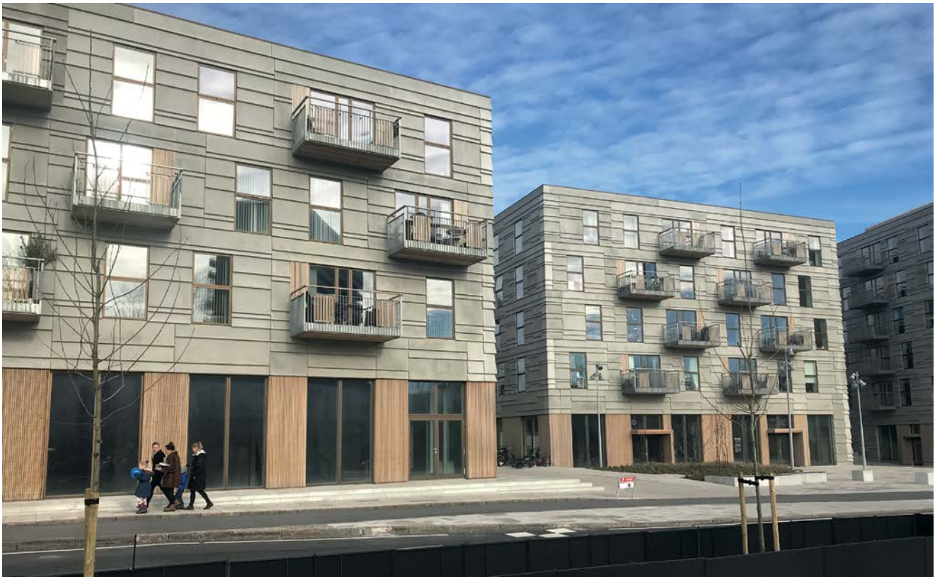
Lättklinker användes för dränering i källaren och ovanpå ett parkeringsgarage.
