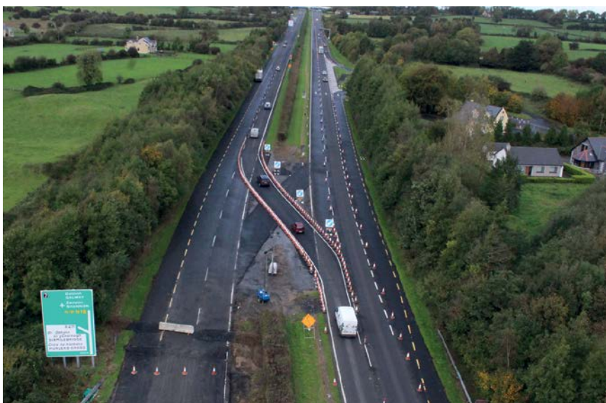
Leca Lättklinker var en viktig komponent vid renoveringen av den 1,6 kilometer långa motorvägssträckan.
