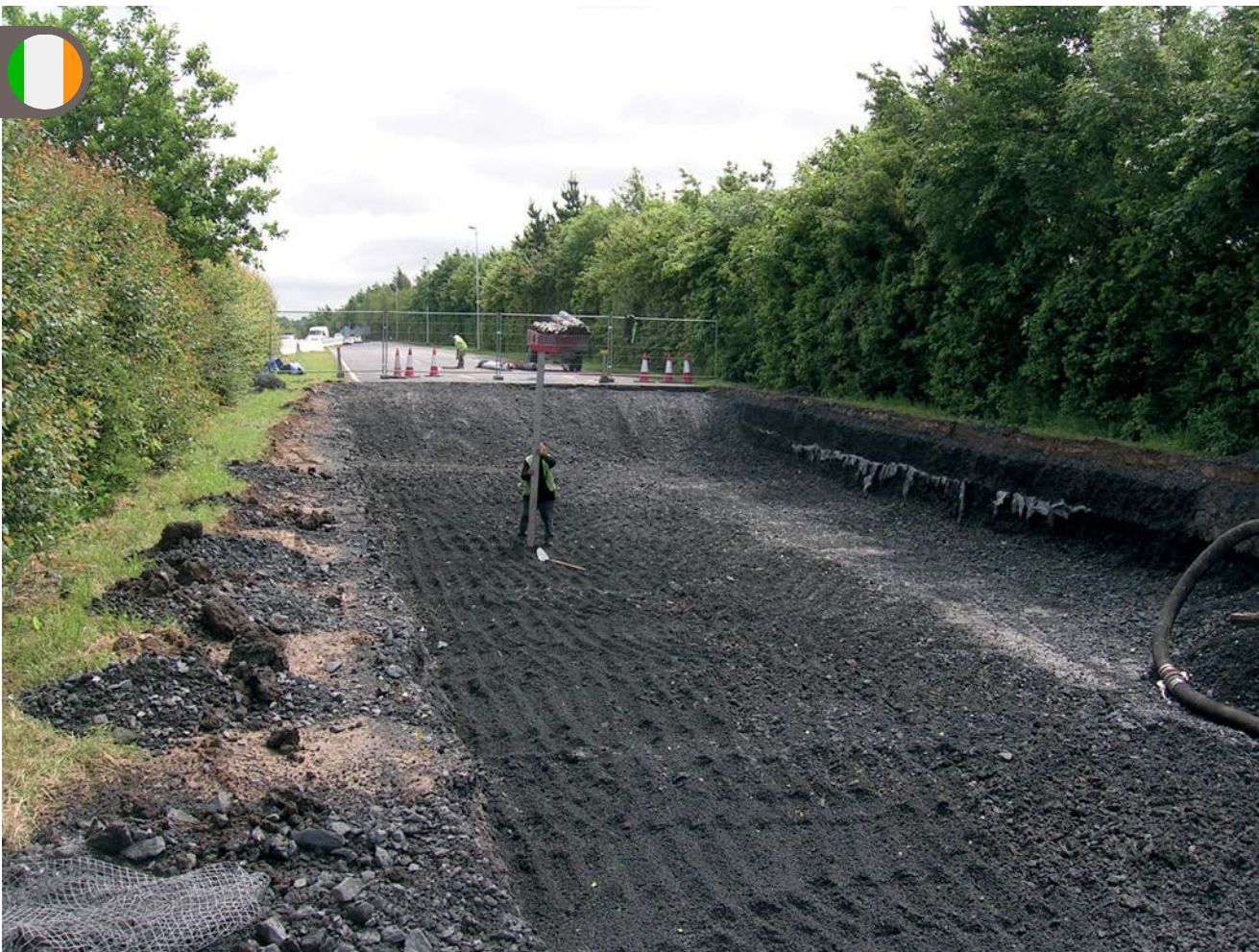
Leca Leichtklinker användes för att ersätta tungt material i vägkonstruktion.
