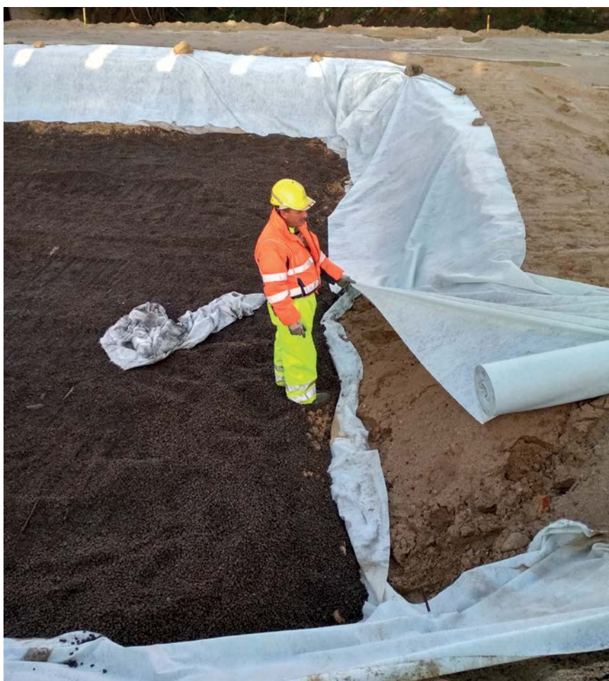
Utläggning av geotextil i polypropen (250 g/m 2 ).
