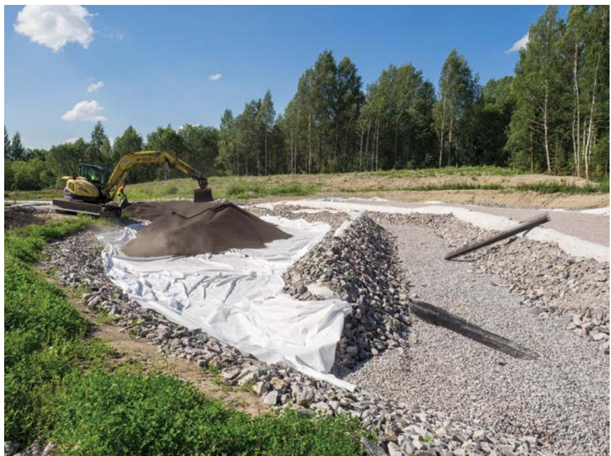
Den andra sektionen innehåller krossad Leca Lättklinker (kornstorlek 3–8 mm) tillverkad vid Leca Finlands fabrik i Kuusankoski.
