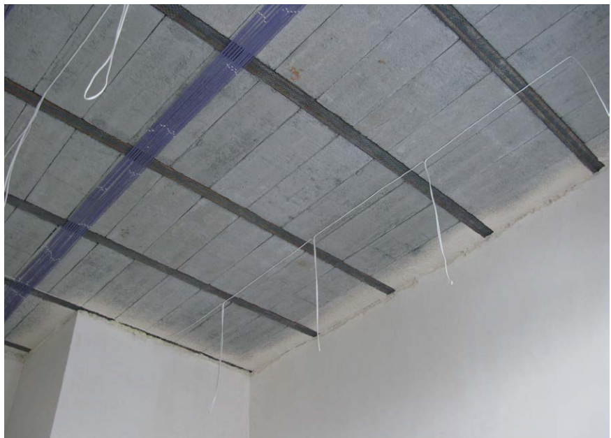
WPS-tak sett underifrån
