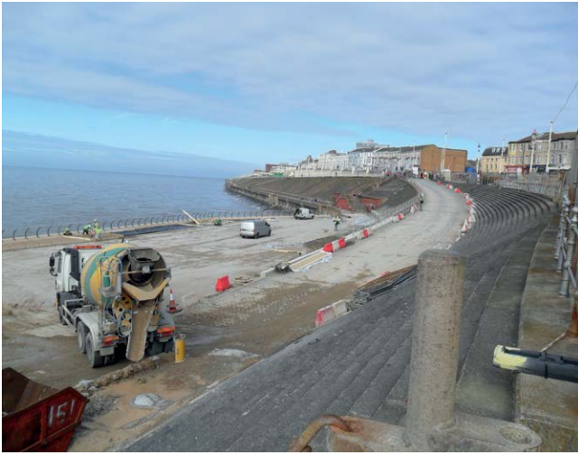
4 000 m 3 Leca Lättklinker användes för utfyllnad mellan de befintliga och nya skyddsvallarna mot havet.
