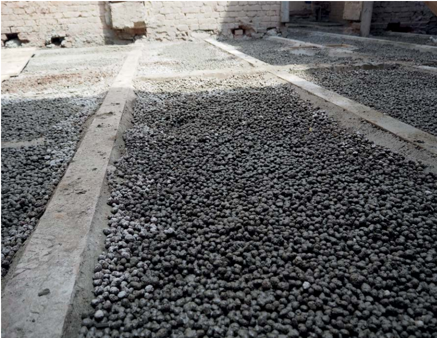
Leca Lättklinker mellan balkarna i innertaket
