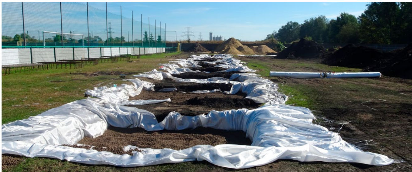
Avlastar marken under fundamentet.
