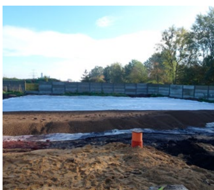
Fyllnadsmaterial under parkeringen.
