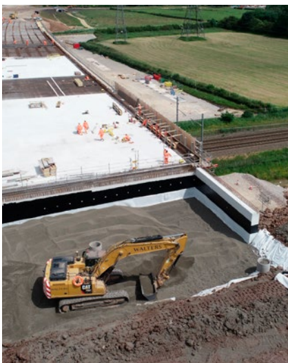
Leca lättklinkers robusta lättviktsegenskaper blev en avgörande lösning på de dåliga markförhållandena
