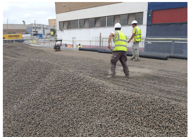
Manuell utläggning i områden nära väggar.
