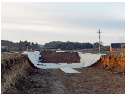
Ett 0,7 m tjockt lager med lättklinker.
