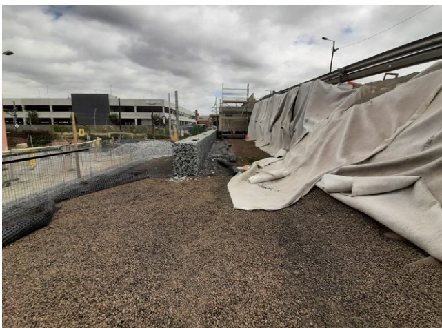
Omslutning av Arlita® genom gabionväggar och användning av geonät.
