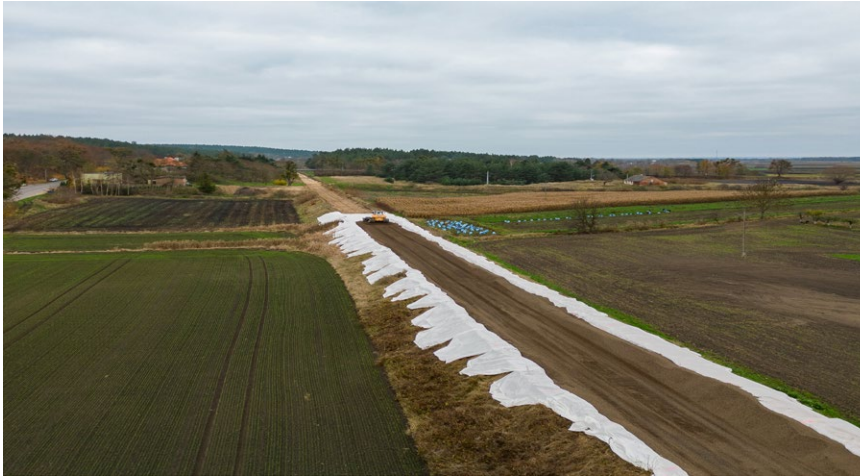
För att säkerställa stabiliteten designades en markavlastning med hjälp av Leca lättklinker.
