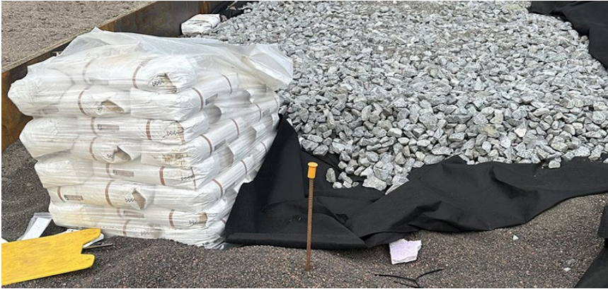
Ovanför betongytan finns gröna områden som är anlagda med krossad Leca® lättklinker 2/10, för magasinering, dränering och infiltration av dagvatten.
