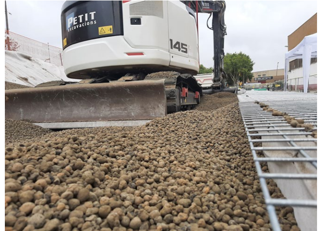
Packning av materialet med hjälp av bulldozers.
