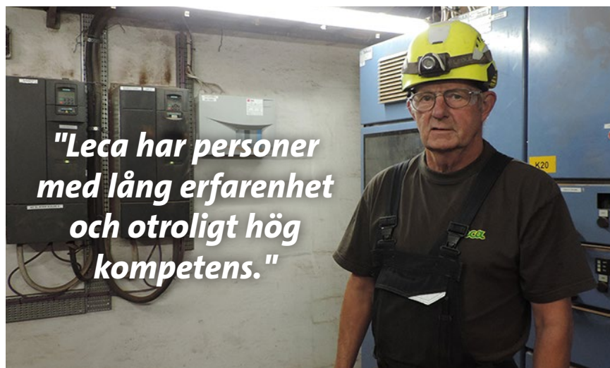
Bo är elektriker och har arbetat på Leca i 47 år på anläggningen i Hinge - "Jag är stolt över att vi kan erbjuda en arbetsplats där man vill vara i så många år."
