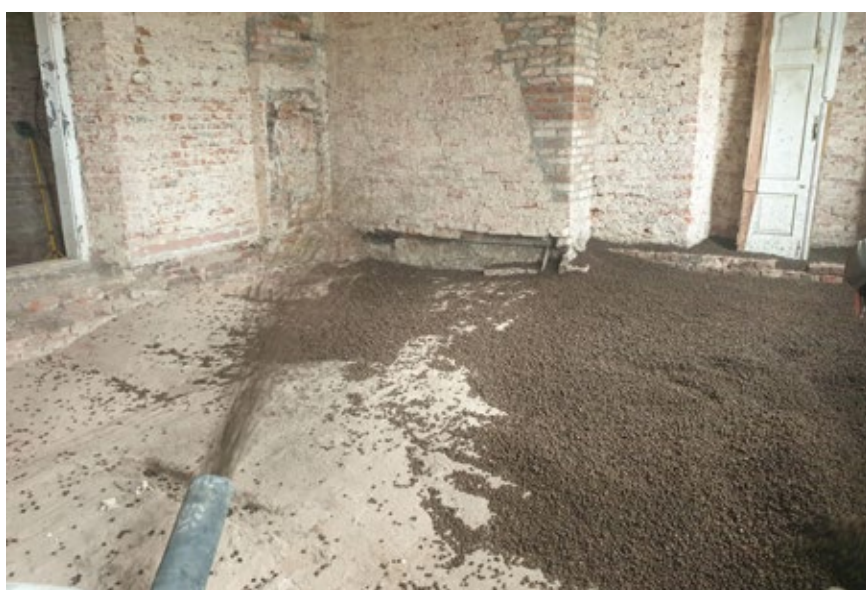
Läggning av lättklinker via blåsbil.
