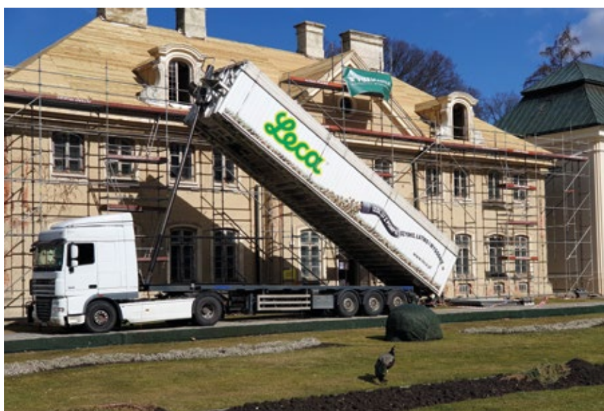
Fordon för blåslossning av lättklinker.
