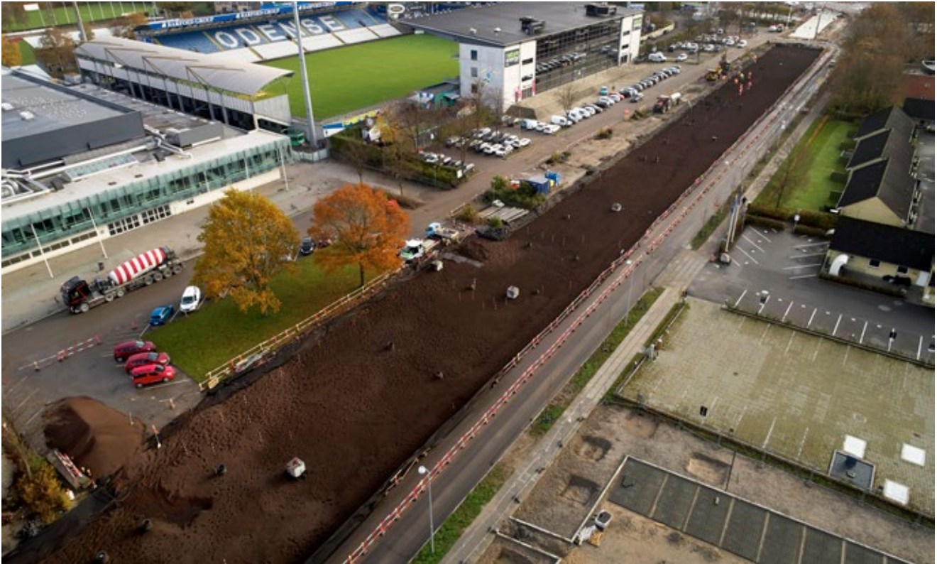
Sammanlagt 4 200 m 3 Leca Lättklinker gick åt till den 300 meter långa sträckan Bild: MT Højgaard
