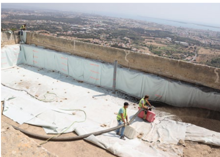
Leca Lättklinker pumpades direkt på plats med hjälp av blåslossning.
