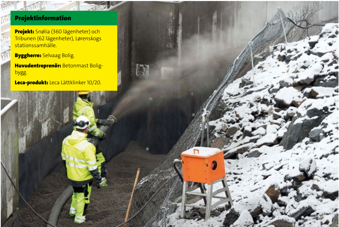
Andrzej Bojarczuk (vänster) och Eirik Navelsaker ser till att återfyllningen inte skapar för stort tryck på byggnaden.
