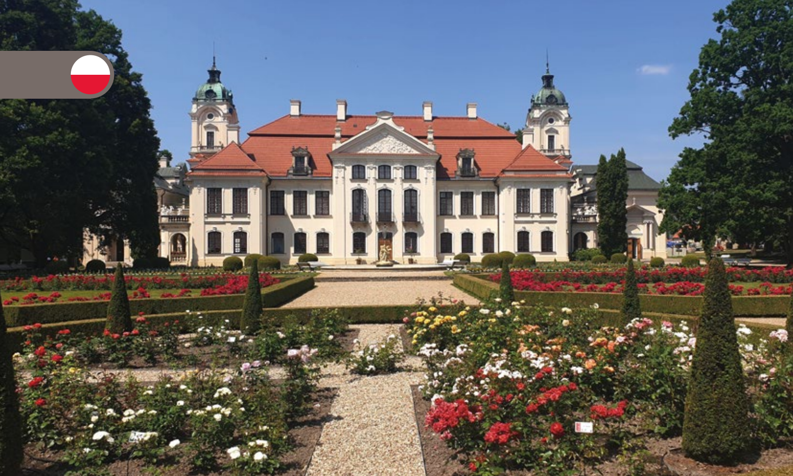
Zamoyski-museet efter renoveringen
