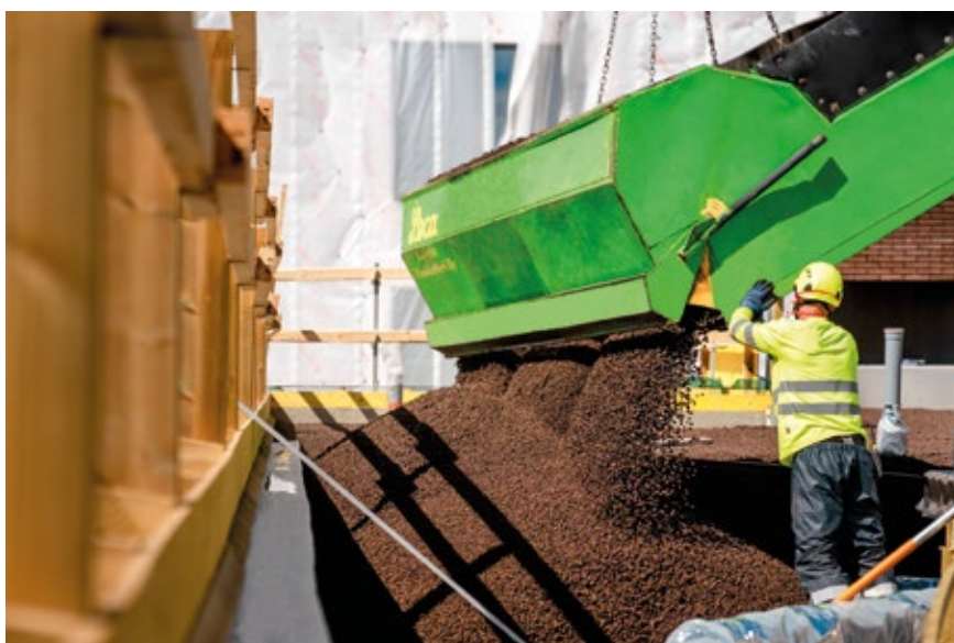
Leca Lättklinker levererades snabbt och enkelt via en lyftcontainer.
