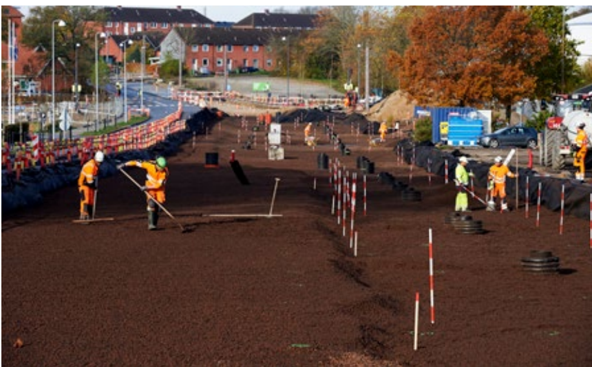
Ett 70 cm tjockt lager med Leca Lättklinker användes i projektet. Bild: MT Højgaard
