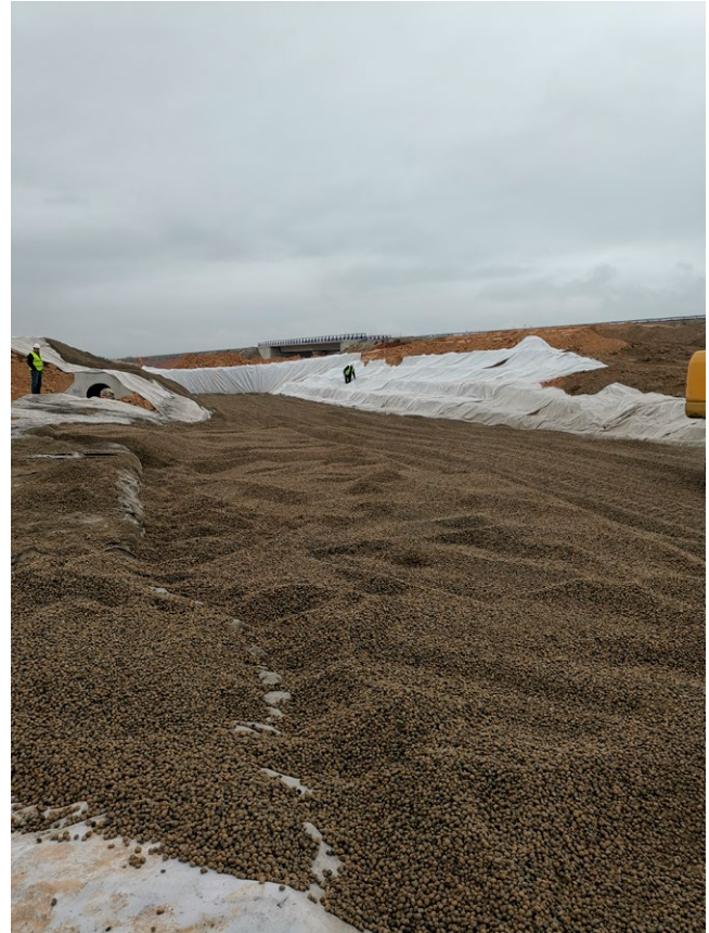
Lättfyllnad före packning.
