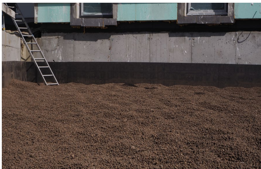
Fyllning i anslutning till byggnad och stödvägg
