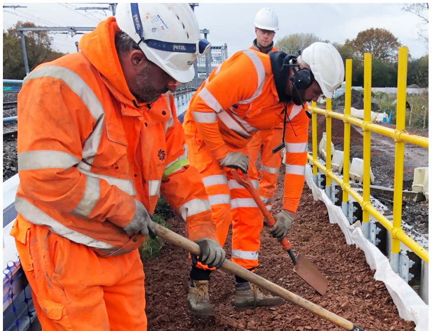
Lös Leca Lättklinker (10/20) levererades via trailer med walking floor
