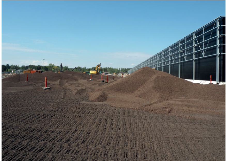
Lagret med Leca Lättklinker i den yttre markkonstruktionen är mellan 30 och 120 centimeter tjockt.
