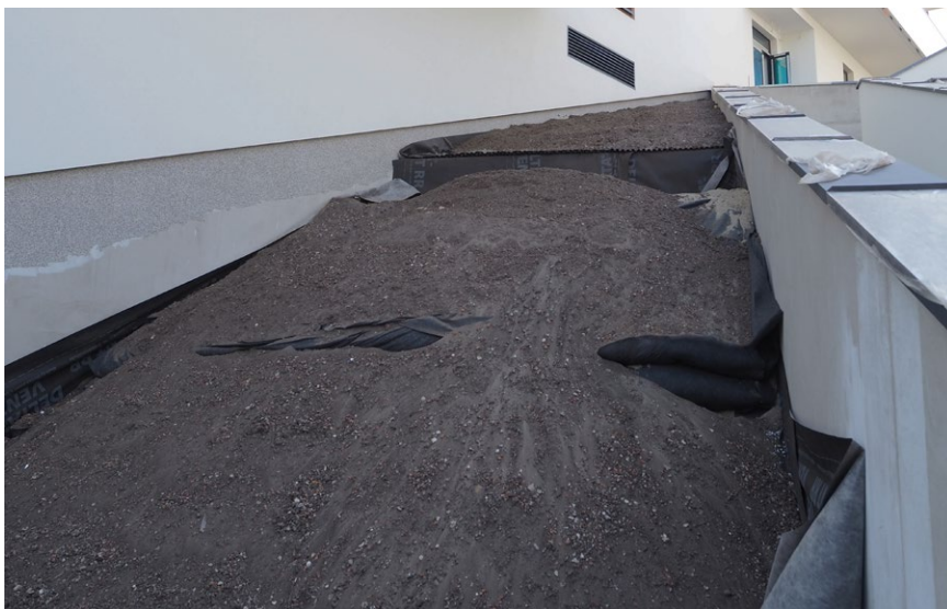
Slänter skapade av "madrasser" innehållande lättklinker
