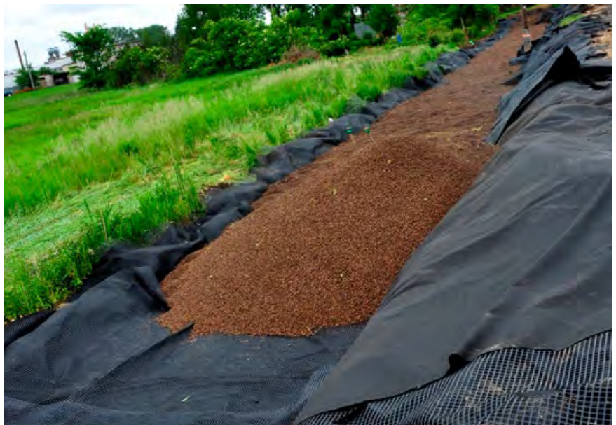
Leca lättklinker läggs ut
