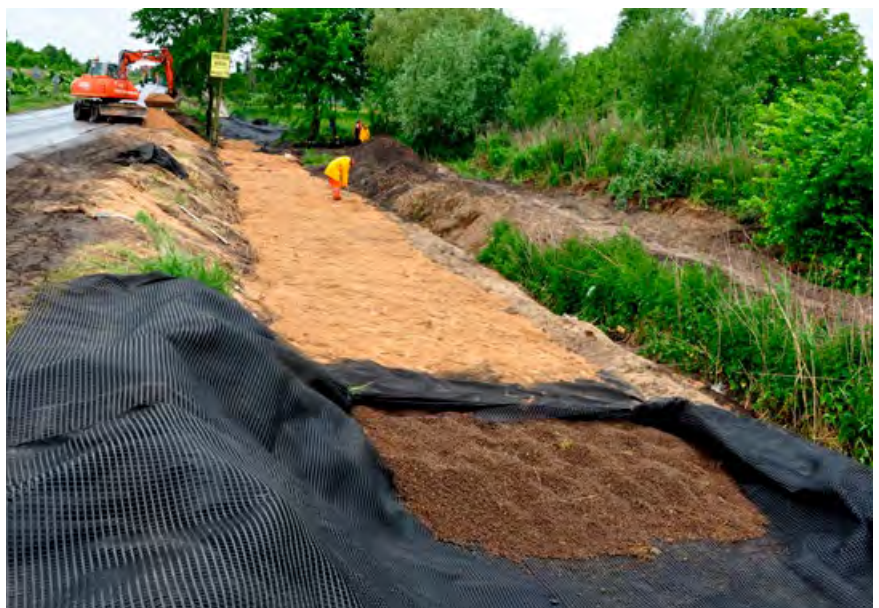
Fyllnadsmassan och underbyggnaden för vägbanan täcks
