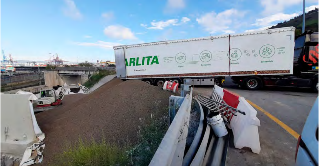
Tack vare den minskade markbelastningen med Leca lättklinker behövde man inte vidta andra åtgärder än att avlägsna befintlig vegetation.
