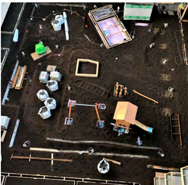
För att fördela materialet över innergården användes en vanliga asfaltsraka.
