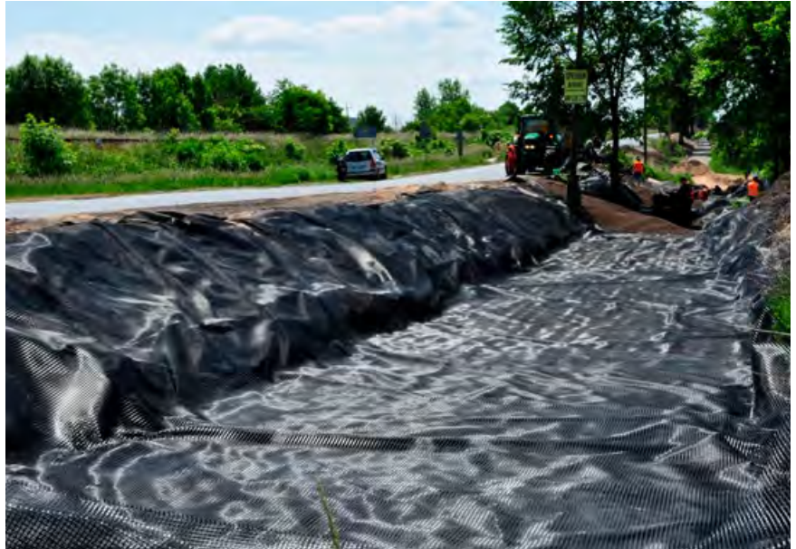
Geotextil läggs ut
