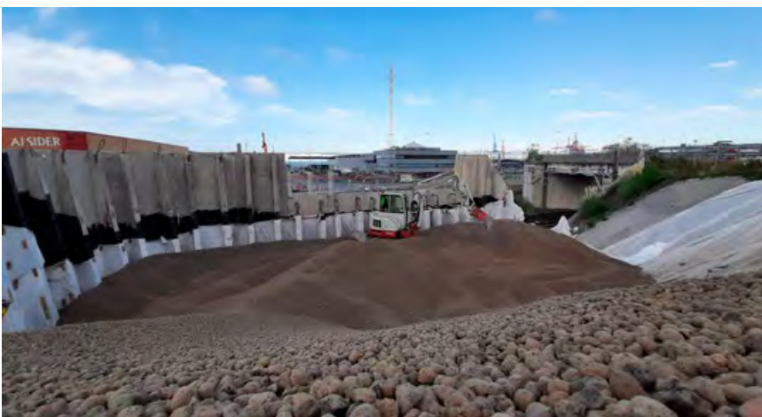
Fyllningen på brofästet gjordes med Leca lättklinker för kontrollerbara sättningar i framtiden.
