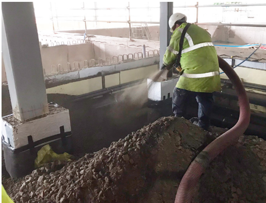
Leca lättklinker hade nödvändiga strukturella egenskaper för att klara belastningen från en 150 mm tjock betongplatta.
