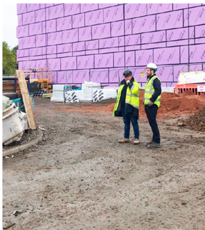
Leca lättklinker krävde 50 % mindre arbete än vad fyllnad av GSB-typ skulle ha gjort.
