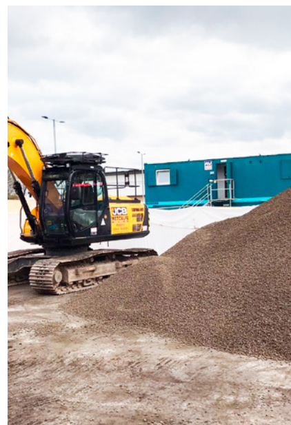
Leca lättklinker sparade in drygt tio dagars arbete i projektplanen samtidigt som det förbättrade bassängens värmevärden.
