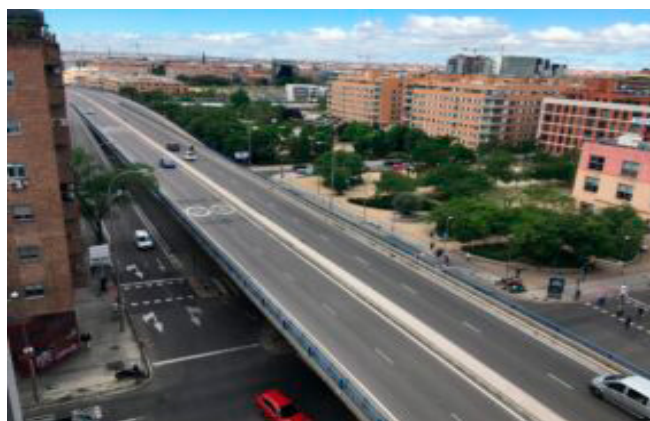
Området före och efter förbättringsarbetet.
