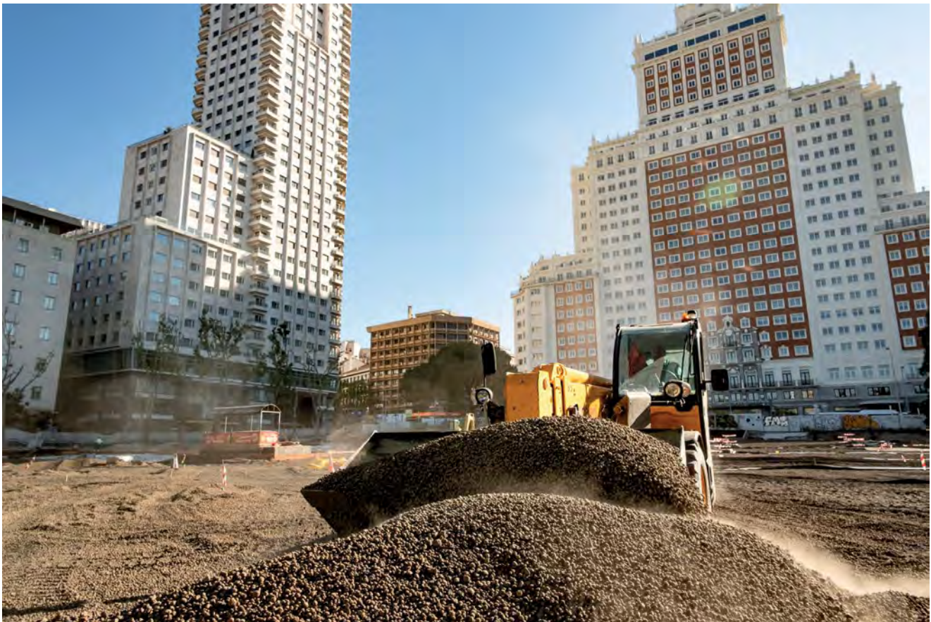
Utläggning och packning av Leca Lättklinker på det 10 000 m 2 stora torget.
