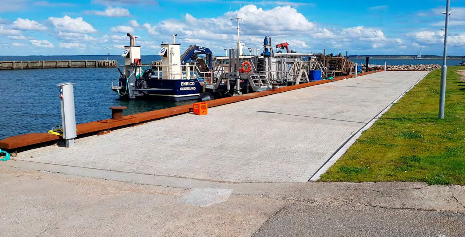
Den färdiga kajen med beläggning ovanpå Leca Lättklinker.
