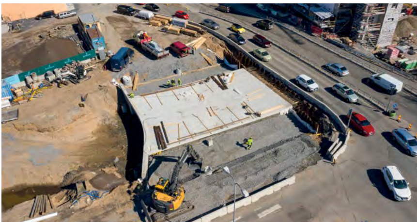
En mellanlagringsstation anlades för materialet på byggsplatsen.
