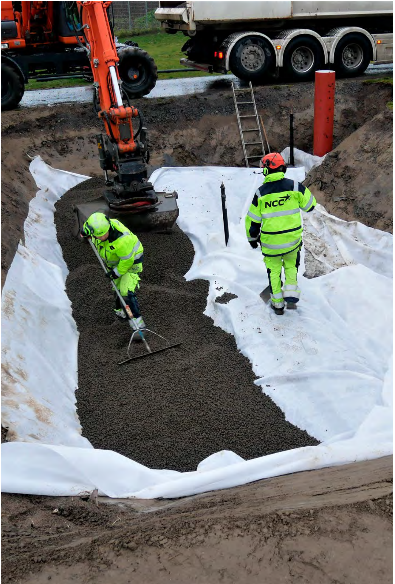
Vid utveckling av en ny principlösning för rörgravar utfördes ett fullskaletest.
