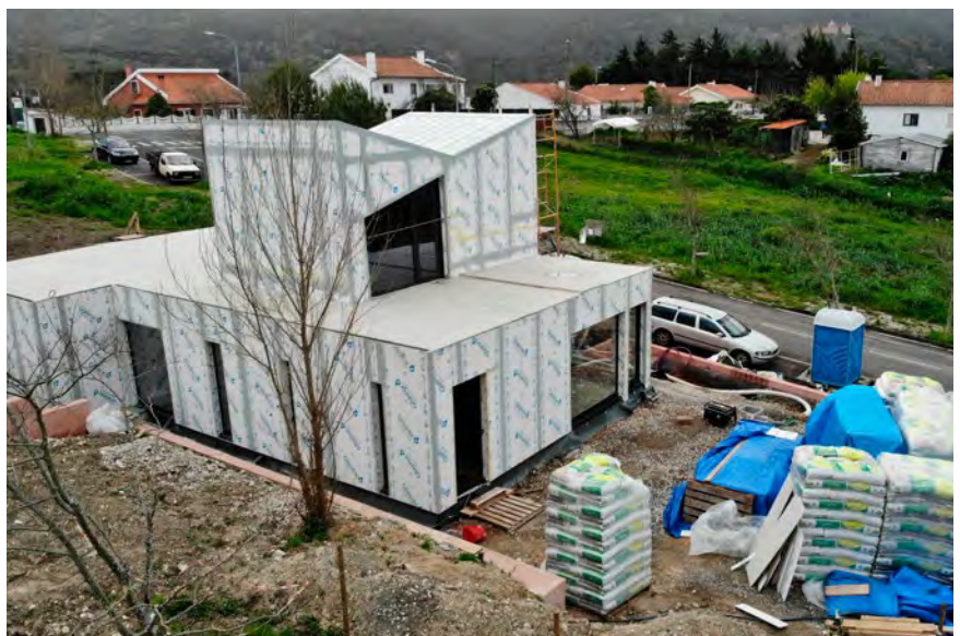
Sexhundra säckar Leca® Dry gick åt till isoleringen av golven.
