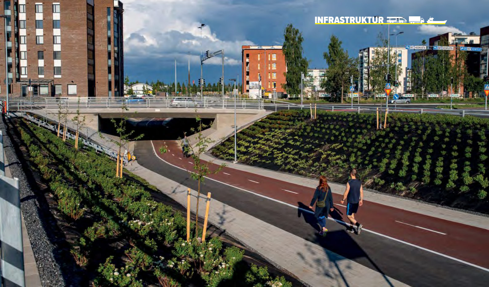
Underfarten vid Rautionpolku stod färdig i november 2019.
