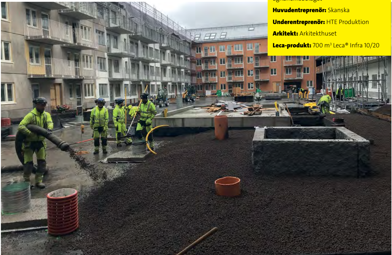
Att materialet kunde blåsas ut gjorde det möjligt för markentreprenören HTE Produktion att hinna ikapp tidsplanen.
