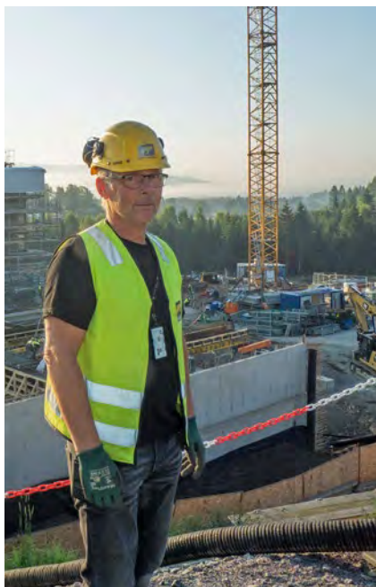
Bygglederen Svein Harald Øyhus inväntar dagens första leverans av lättklinker i morgonsolen.
