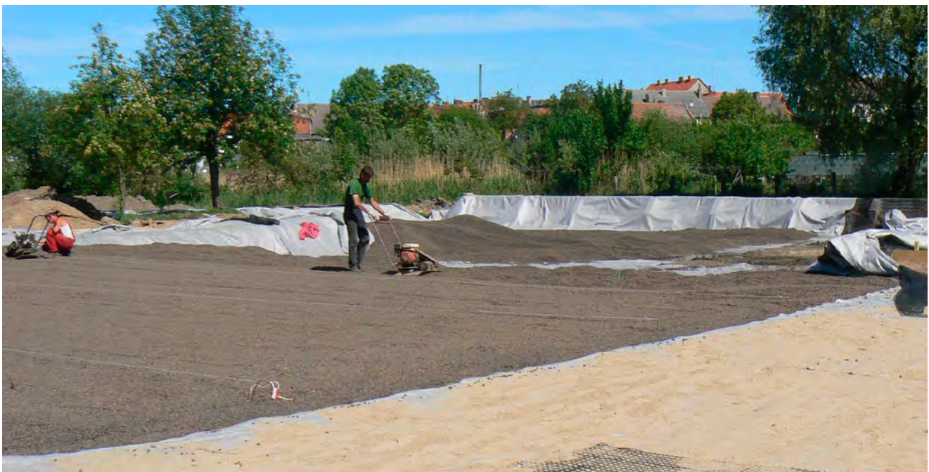
Läggning av det första lagret Leca Lättklinker.
