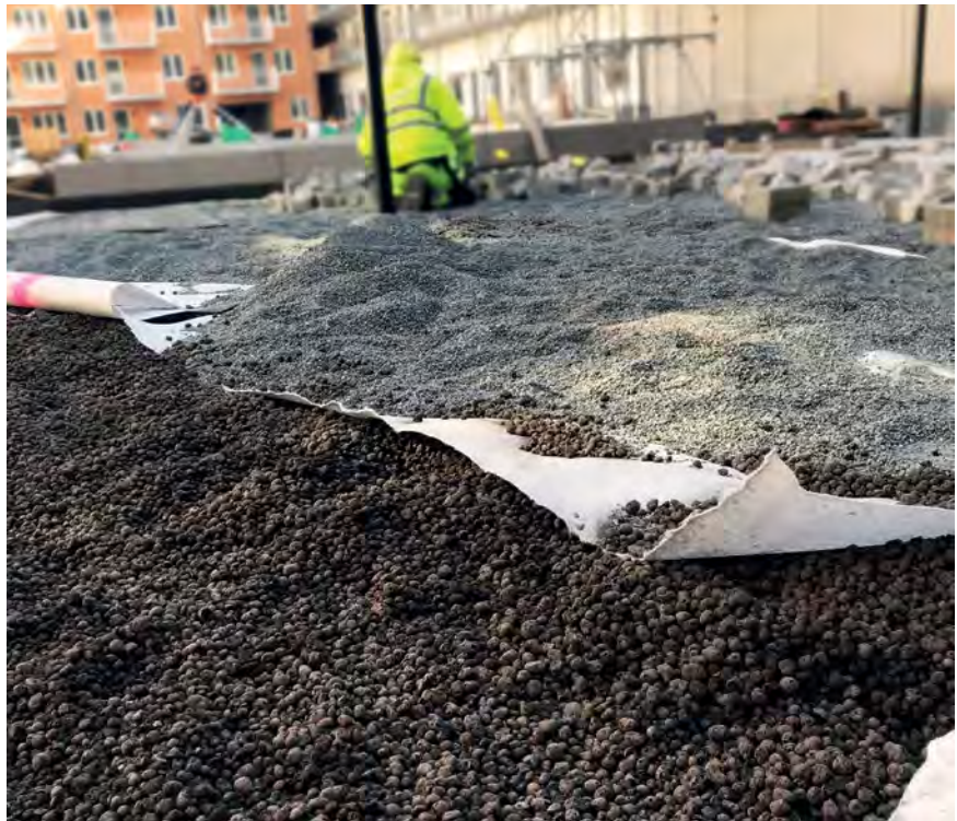
Att använda Leca Lättklinker gjorde arbetet enklare.
