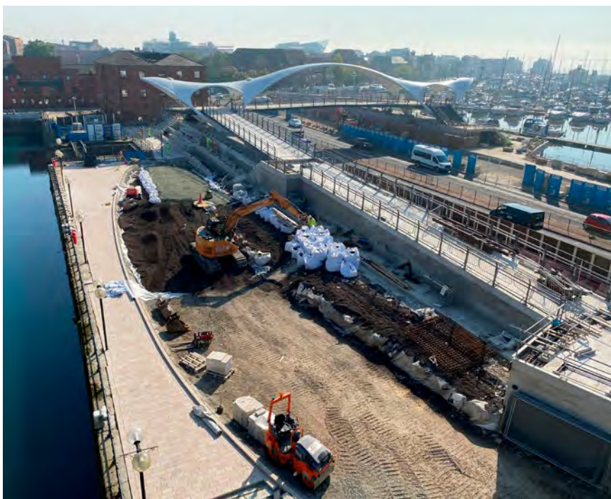
Leca® Lättklinker användes som fyllnadsmaterial i ett sex meter högt utrymme.
