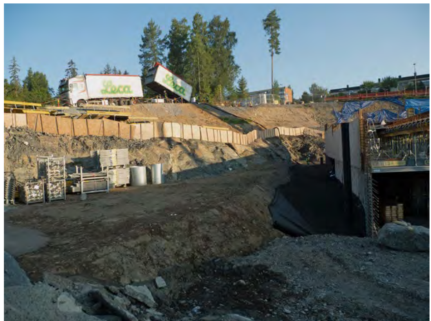
Vid arbeten i brant terräng där man behöver få ned lättklinkern i en byggrop och runt hörn är det idealiskt att kunna blåsa den på plats.
