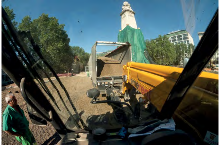
Lossning av Leca Lättklinker från en lastbil med en kapacitet på 75 m 3 .
