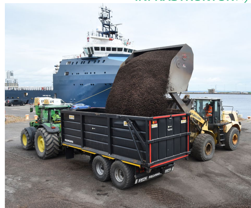
11 000 m 3 av Leca® lättklinker levererades med fartyg direkt till hamnen i Leith i Edinburgh.
