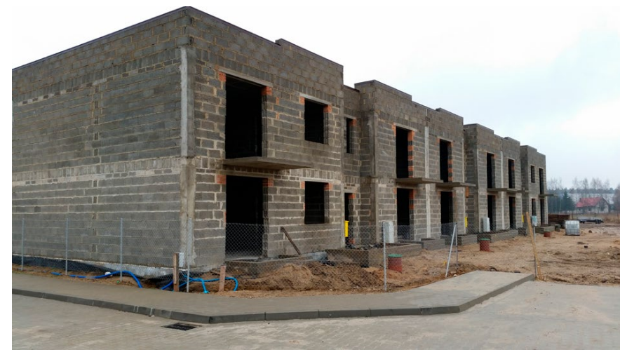
Ett radhus under uppbyggnad.
