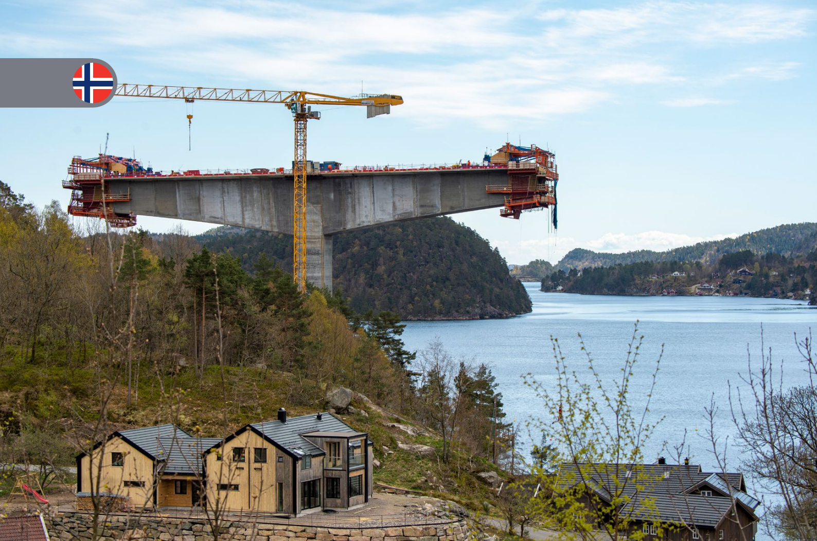
Gjutningen av 260 meter långa spann 64 meter upp i luften ovanför Trysfjorden är precis på gränsen för vad som är möjligt.
