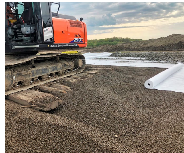
Ett lager av geotextil lades först ut innan lättklinkern installerades.
