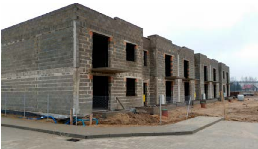
Ett radhus under uppbyggnad.
