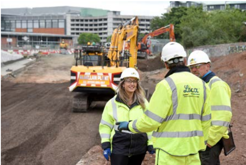
Leca Lättklinker valdes som lättviktslösning för att få ett robust underlag för spårbädden mellan två befintliga stödmurar.
