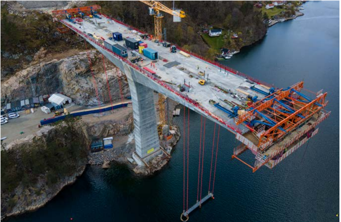
Nye Veiers E39 -projekt mellan Kristiansand och Stavanger är Norges största vägprojekt.
