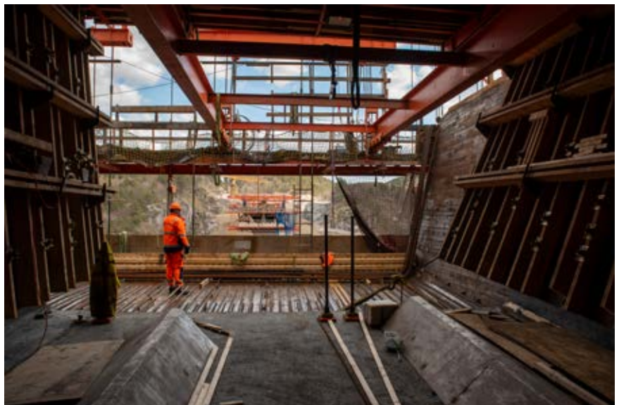
Gjutformsvagnarna används för att gjuta fem meter av brospannet åt gången på de fyra sidorna samtidigt.
