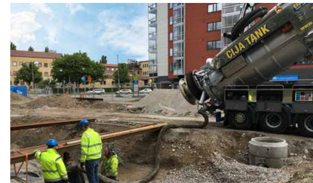
Materiallet blåstes snabbt in med hjälp av en blåsbil.
