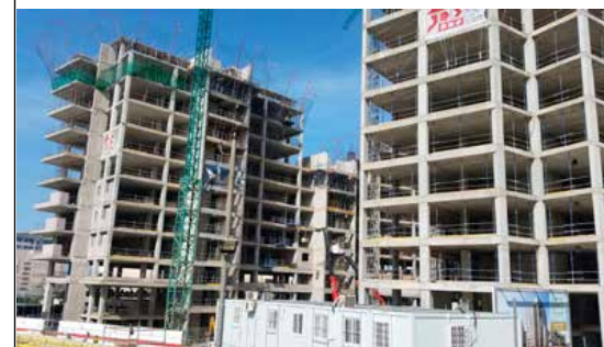
Byggnaden före utplacering av Leca Block.
