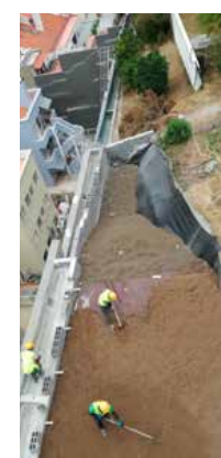
Tomrummet mellan den nya muren och den befintliga sluttningen fylldes med lättklinker.
