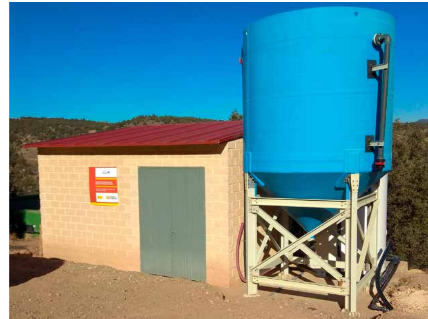
Vy över den lilla anläggningen med sedimenteringstanken på utsidan.
