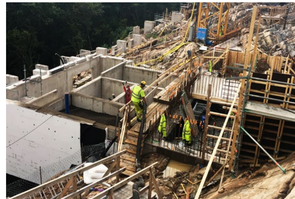
Leca Lättklinker levereras med blås till arbetsplatsen.
