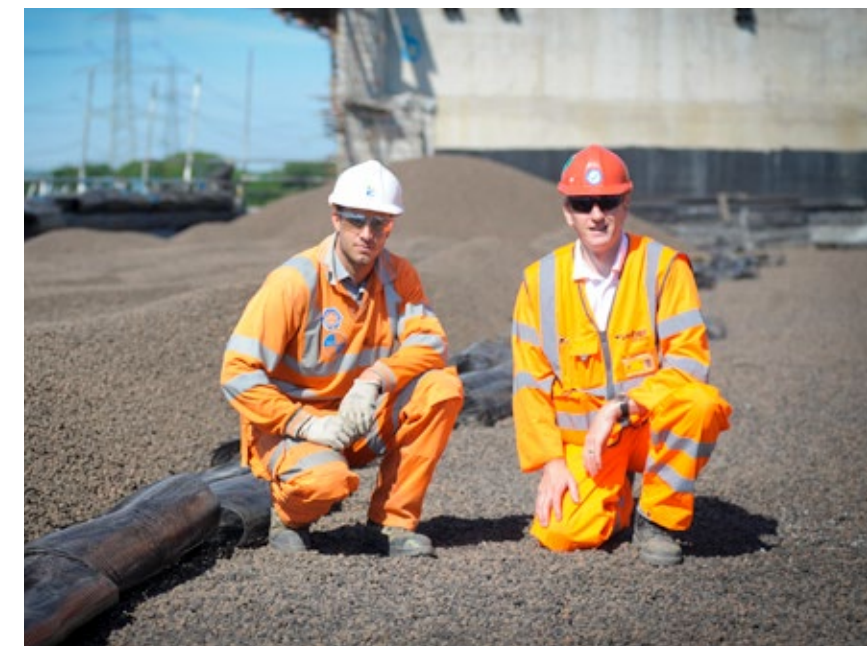
Totalt levererades 26 000 m 3 lös Leca Lättklinker, i lastbilar med så kallat walking floor.
