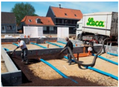
Leca® Lättklinker levererades av vår smarta blåsbil för enkel utläggning.
