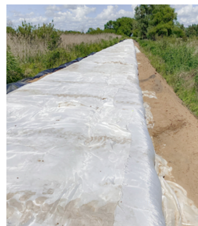
Strukturfyllnad i form av madrasser med lättklinker innesluten i syntetisk geotextil.
