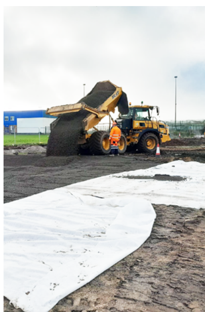
Den lösa marken gjorde att man inte kunde använda konventionella byggmetoder under projektet.
