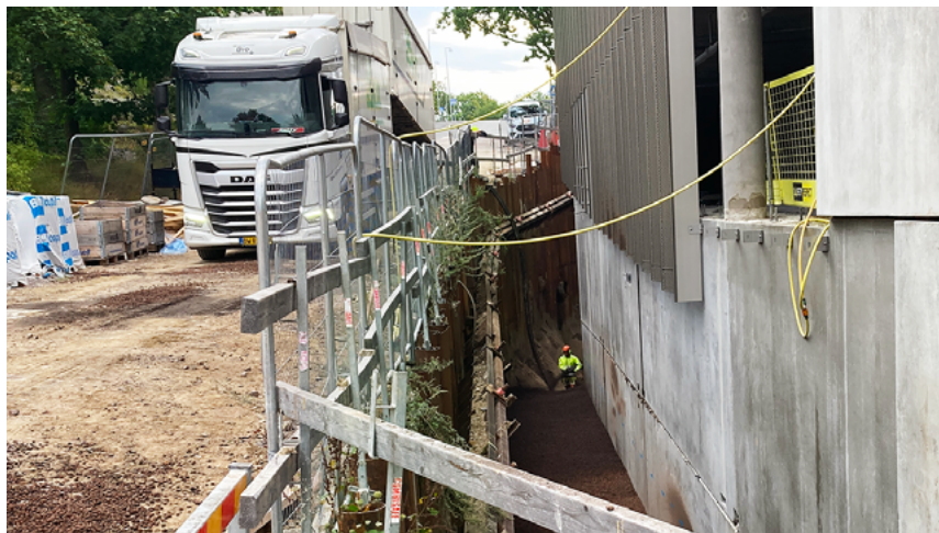
Lättklinker levereras med blåslossning för att nå svåråtkomliga schakt vid parkeringskonstruktionen.
