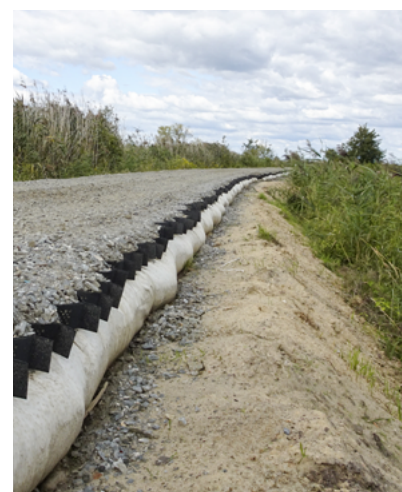
Därefter lades ett 20 cm tjockt ytskikt bestående av 0–31,5 mm lättklinker i geonät.
