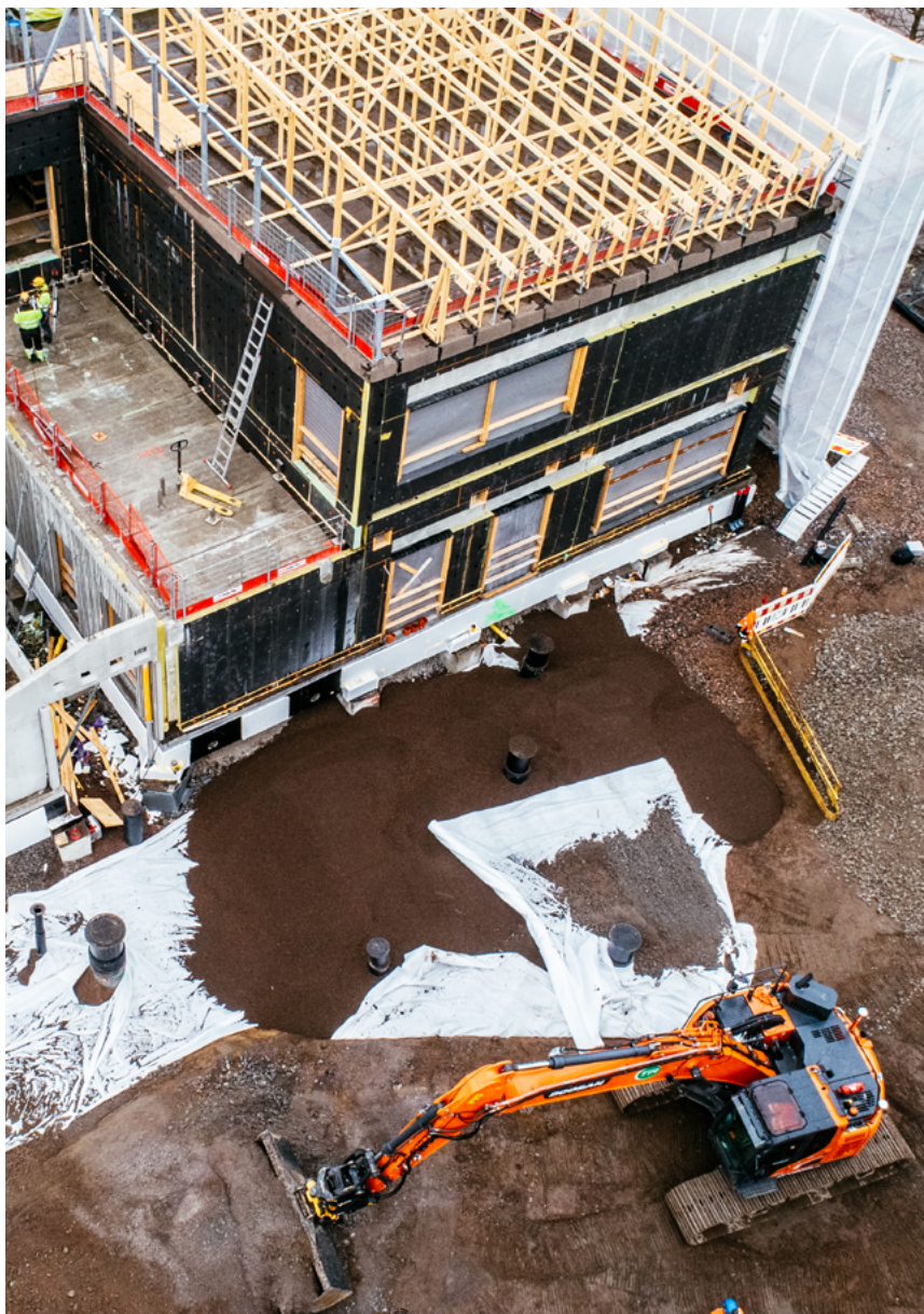
Över 2000 m 3 Leca lättklinker användes som lättfyllnadsmaterial vid Botby grundskola.
