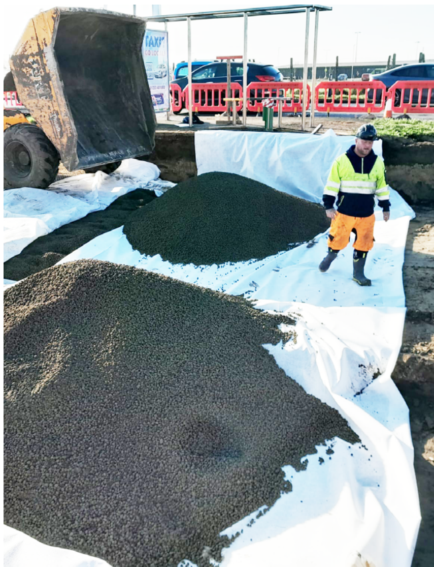
Leca lättklinker valdes som lättfyllnadsmaterial som kraftigt minskar risken för sättningar.
