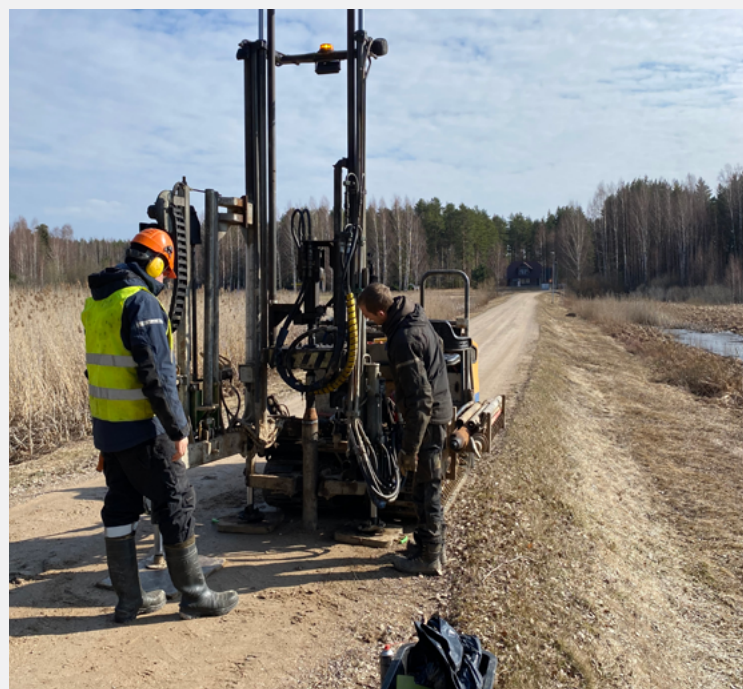
Provboring gjordes i mars 2024 för att bedöma skicket på Leca Lättklinker i vägbanken i Varska.
