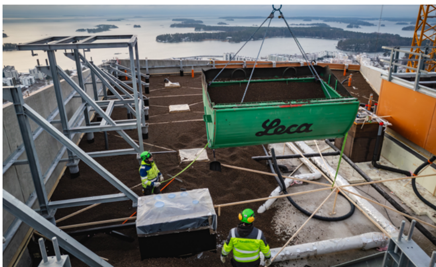
Skickliga arbetare från Kerabit Katto Oy lägger ut Leca Lättklinker med precision.
