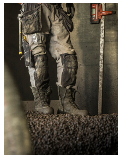
Leca blåslas på plats direkt från lastbilen, helt packat, utan manuell lossning och förpackningar. Och det går alldeles utmärkt att gå på.
