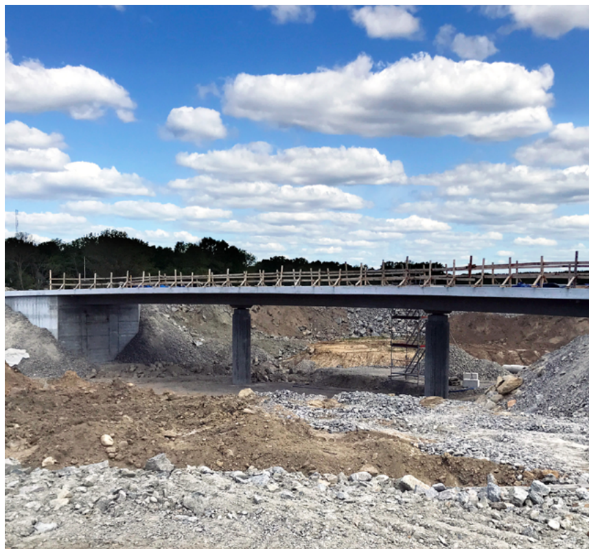
En av de 23 broar som byggs för att förbättra infrastrukturen, där Leca lättklinker förhindrar behovet av ytterligare pållning.
