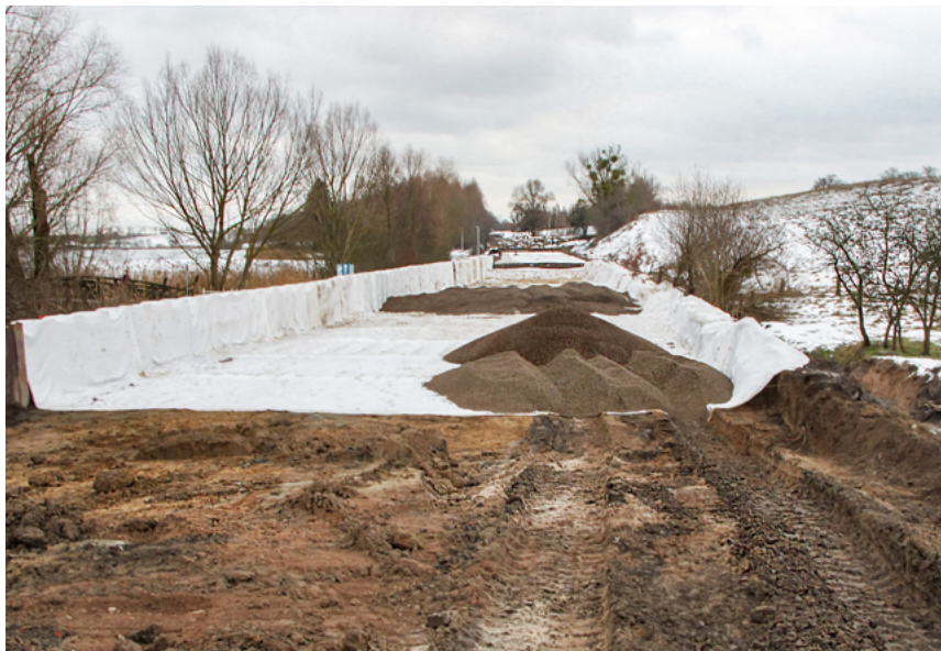
Man valde att använda en geomadrass av Leca® Geoteknisk Lättklinker 8/10–20RX.
