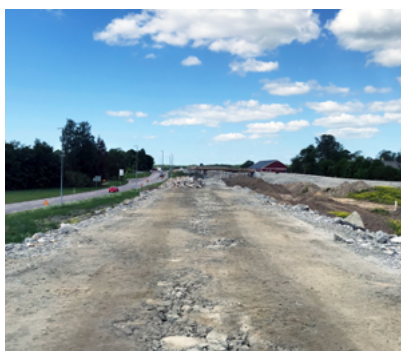
Markarbeten för den nya motorvägen förbättrar kapaciteten och säkerheten för de 15 000 fordon som passerar dagligen.
