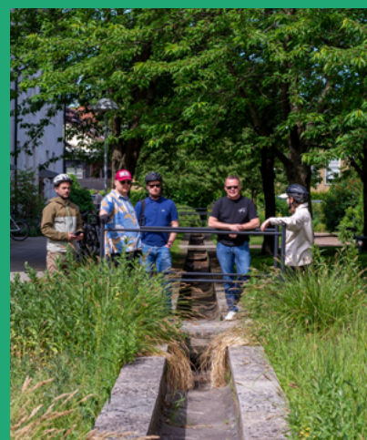
Helen guidar en grupp i Augustenborg, Malmö. Kanalerna fångar upp regnvatten och minskar belastningen på dagvattensystemet. Bild: Essi Malinen-Lallukka
