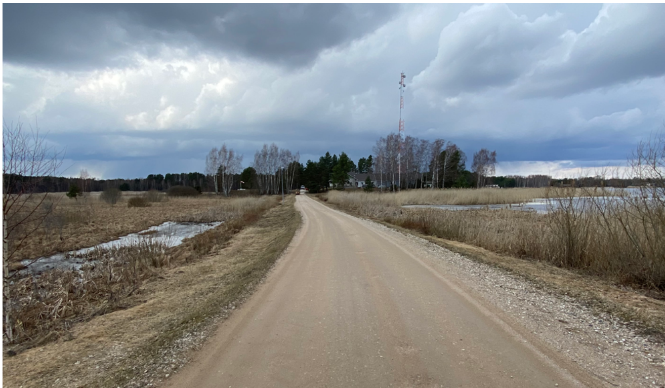
Den 160 meter långa vägsträckan som leder till den estniska gränsbevakningsstationen är fortfarande i utmärkt skick efter att ha varit i bruk i över 24 år.
