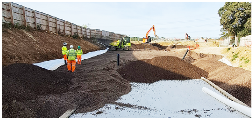
Över 5 600 m 3 Leca lättklinker användes för att stödja kulvertförlängningen innan markarbetena påbörjades.
