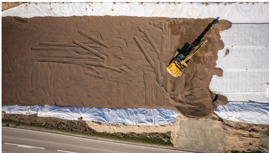
Leca lättklinker kompakterades med bandgrävare.
