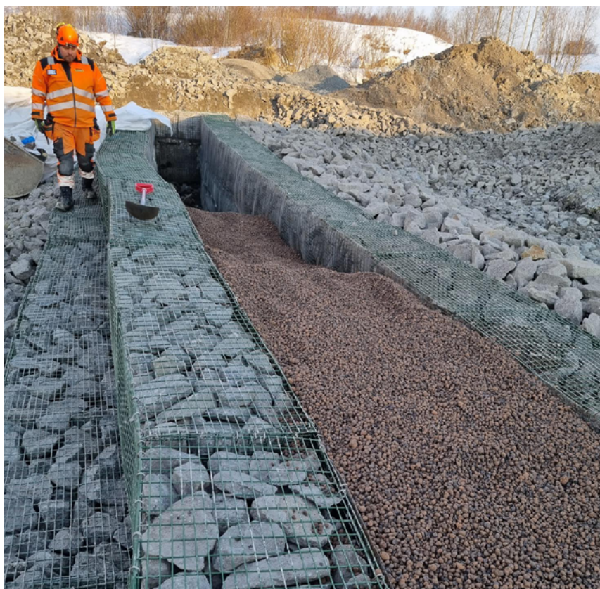
Leca lättklinker placerad i dammens kärna, lätt att byta ut.
