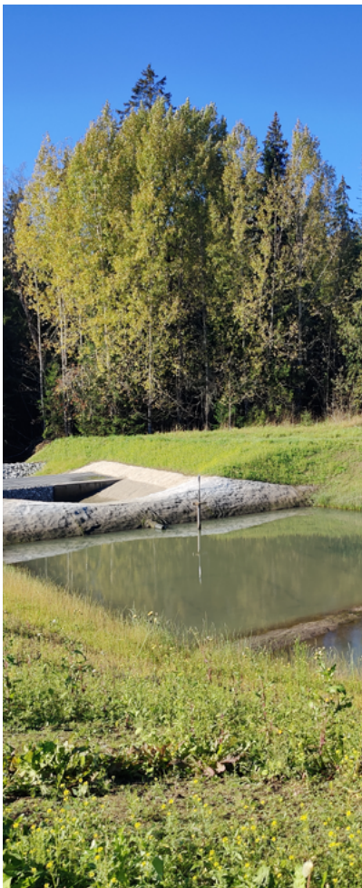
Filterdamm integrerad i ett större behandlingssystem.
