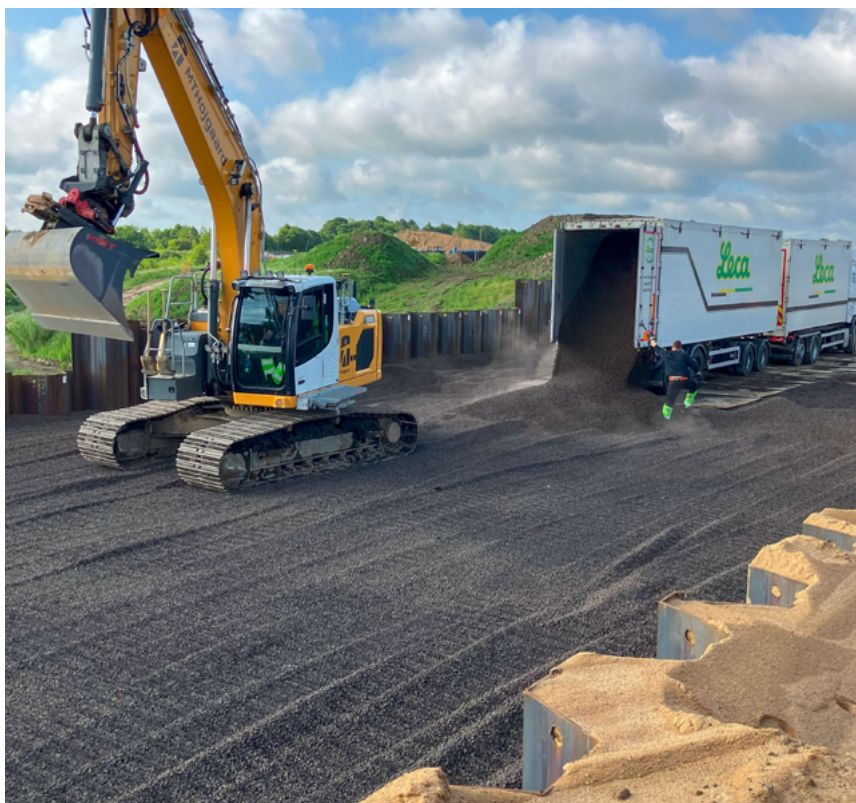
Leca lättklinker läggs ut på motorvägen E45 – minskar belastningen och jordtrycket i vägkonstruktionen.
