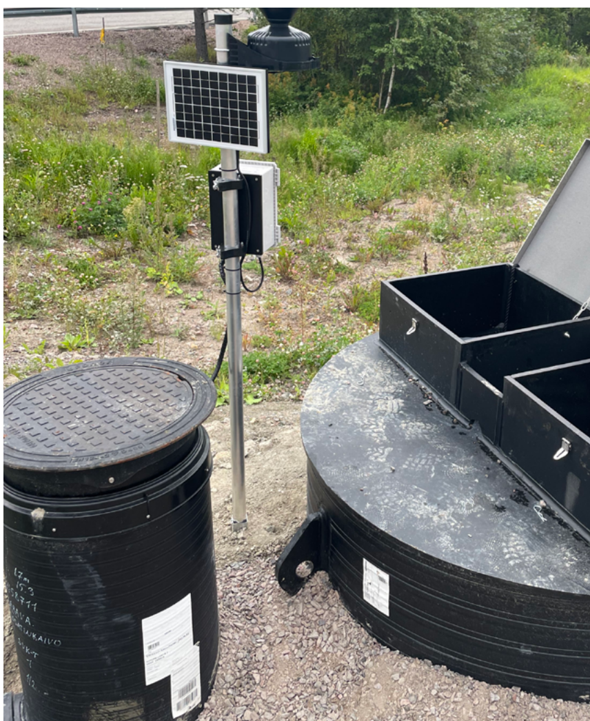
Filterkammare kombinerar sedimentering och Filtralite P-filtrering.
