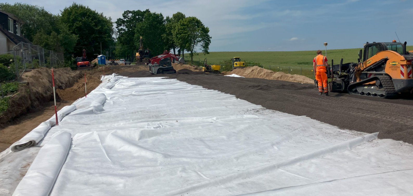
Leca lättklinker inneslöts i geotextil.
