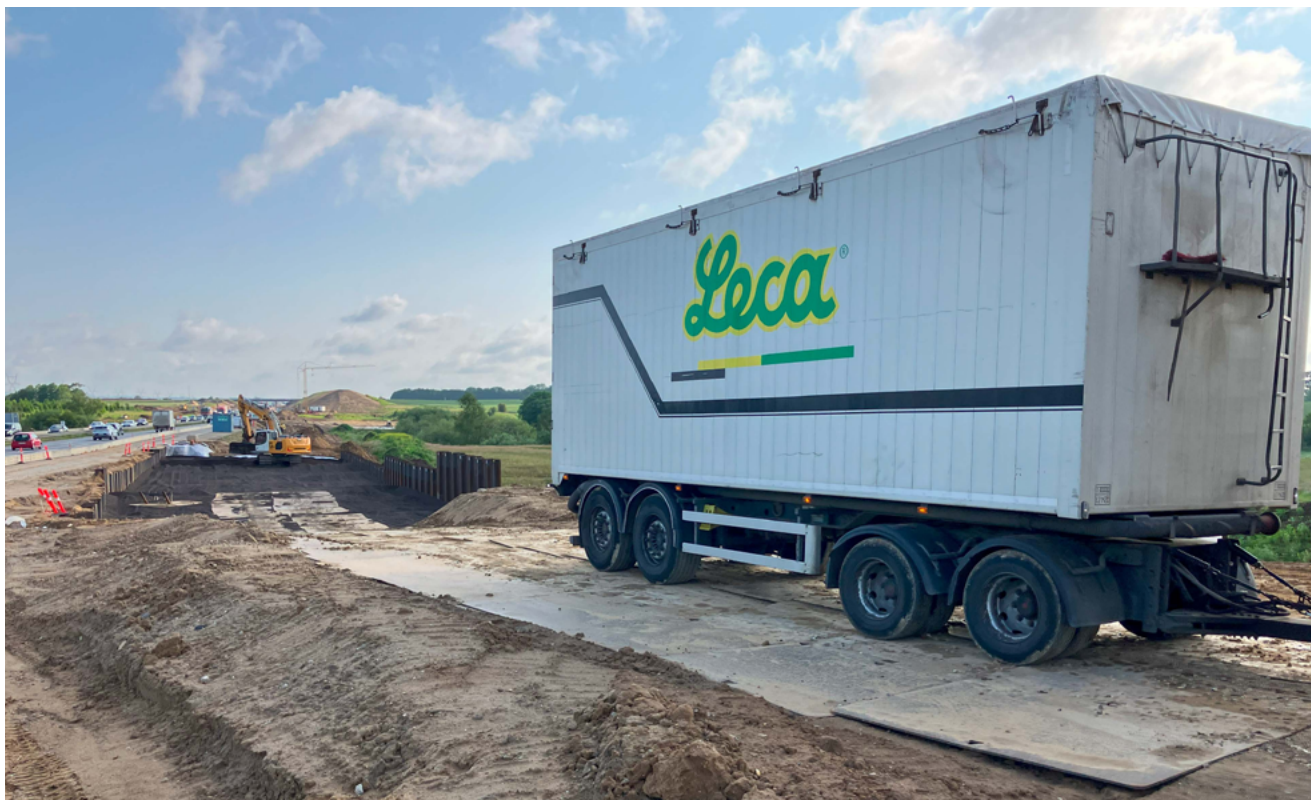
Leverans av Leca lättklinker till E45-projektet. Materialet anländer färdigt för utläggning, vilket säkerställer en effektiv byggprocess.
