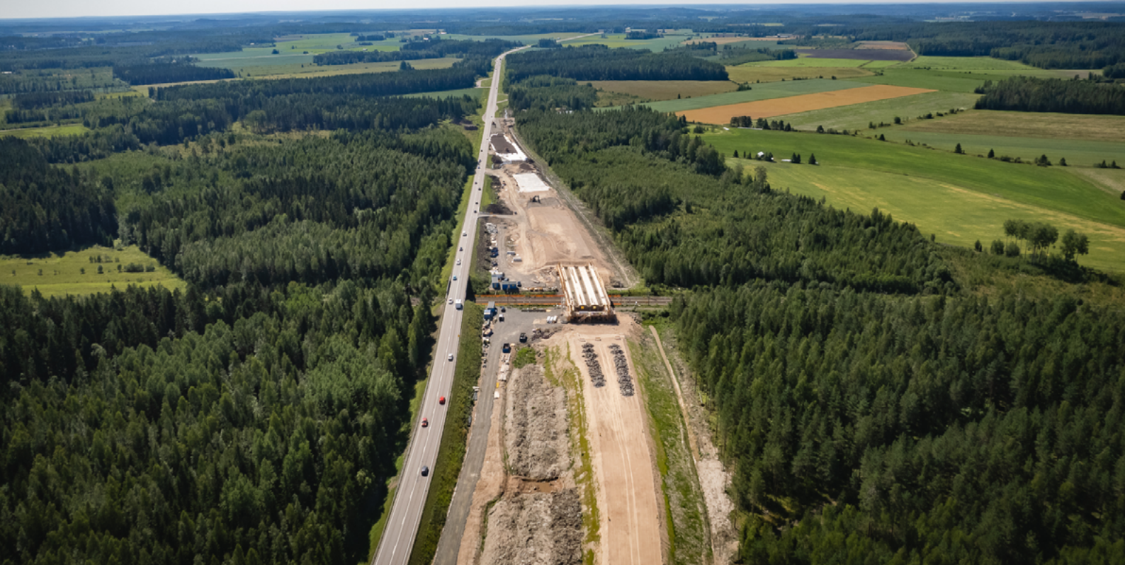
Flygbild över byggarbetsplatsen i Koria.
