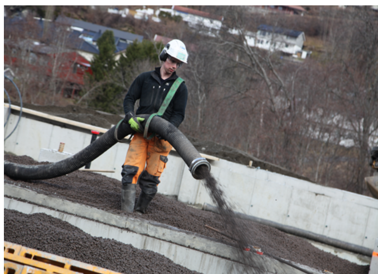
Lättklinker blåses direkt på plats – en snabb och effektiv lösning.
