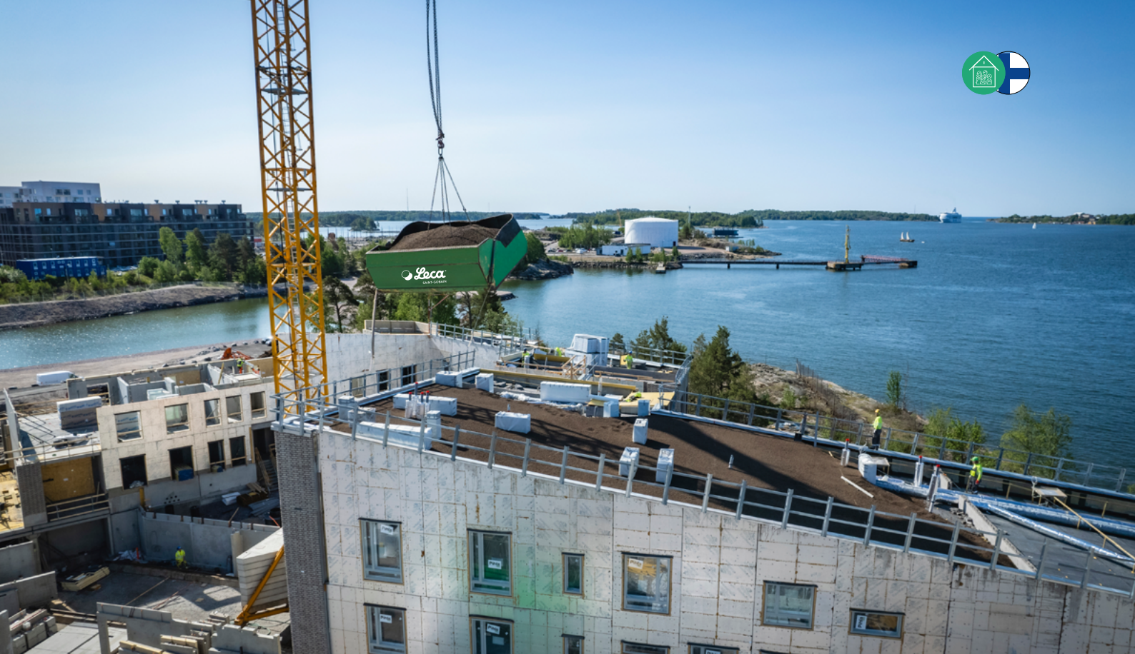
Leca lättklinker levererades upp på taket, 5–9 våningar upp, med hjälp av lyftbox, vilket bidrog till effektiv installation på plats.
