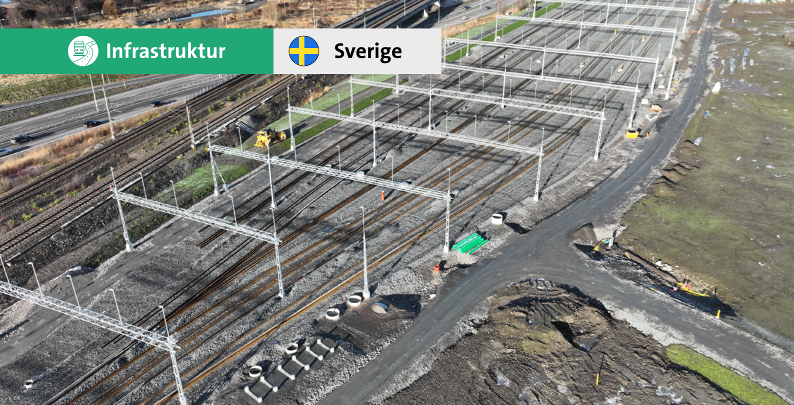
Nya uppställningsspår tar form – utformade för ökad kapacitet och framtidens tågtrafik. Foto: Tim Cato, Trafikverket
