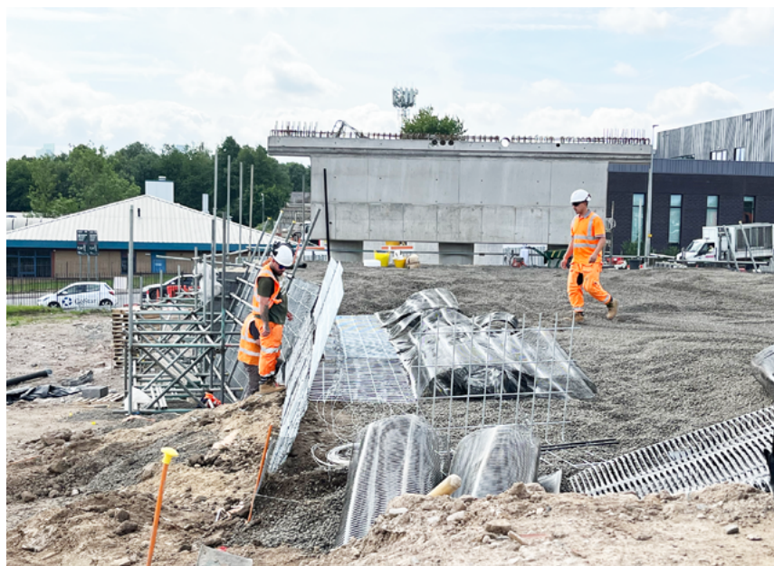
Lättfyllnad krävdes för att minska sättningsrisken och den strukturella belastningen på brostöden.
