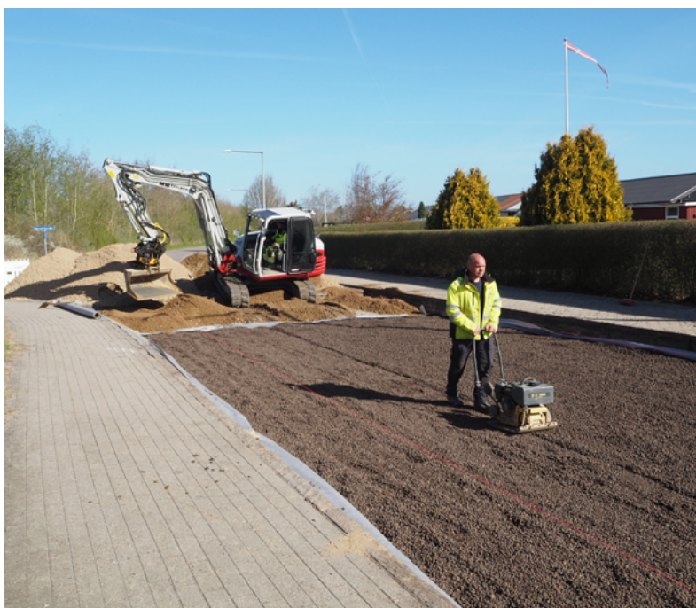
Leca lättklinker ersätter sand som bottenskydd.
