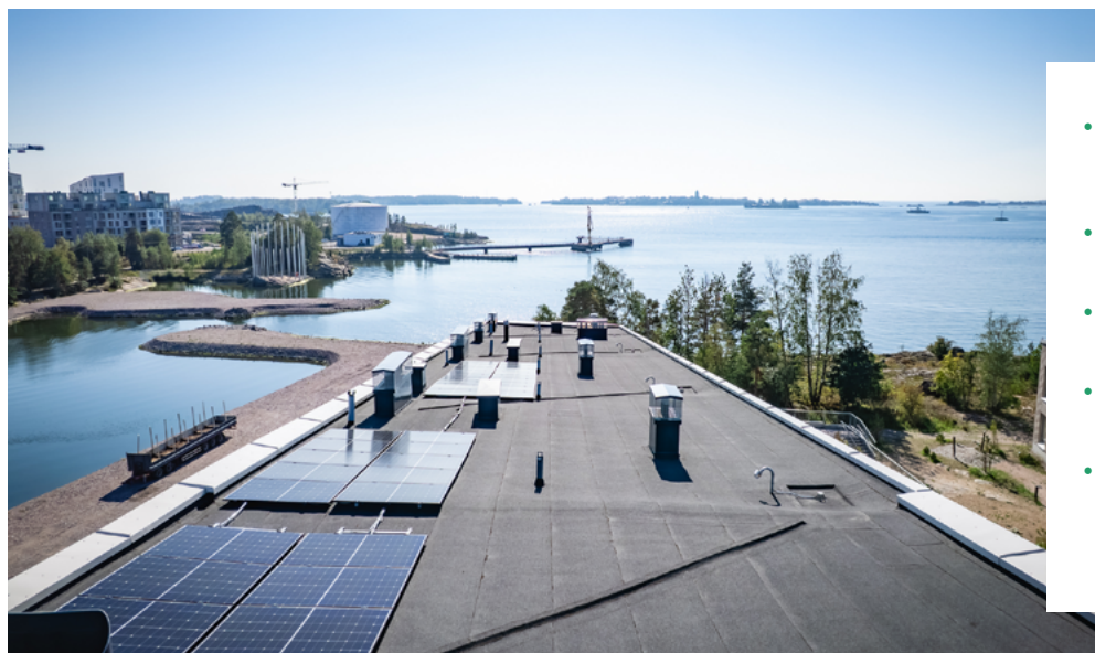
Det färdiga taket integrerar tekniska installationer och solpaneler i en lätt och anpassningsbar konstruktion.
