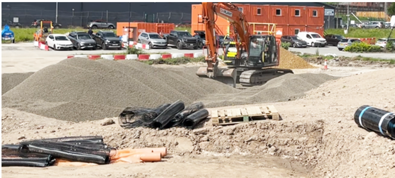
3 000 m 3 Leca lättklinker användes i stödmurar för en ny upphöjd gångbro.
