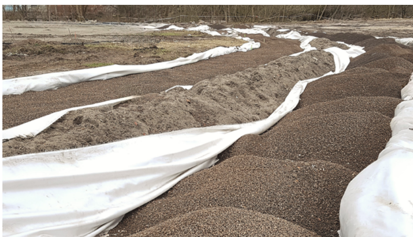
Packad Leca lättklinker (8/10 mm–20 mm) i geoduk bildar lastreducerande "lättklinkermadrasser".
