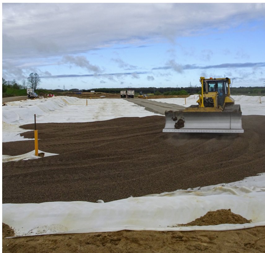
På tre etapper av huvudsträckan lades en bädd av Leca Lättklinker (Leca® GEOTECHNICAL 8/10-20 RX) i flera lager.
