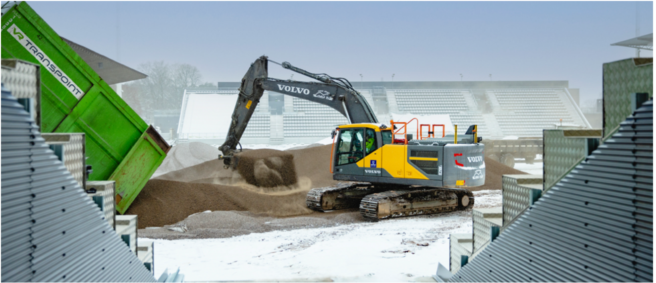
Ett 10–30 cm lager med Leca Lättklinker lades ovanpå den gamla lättfyllnaden.
