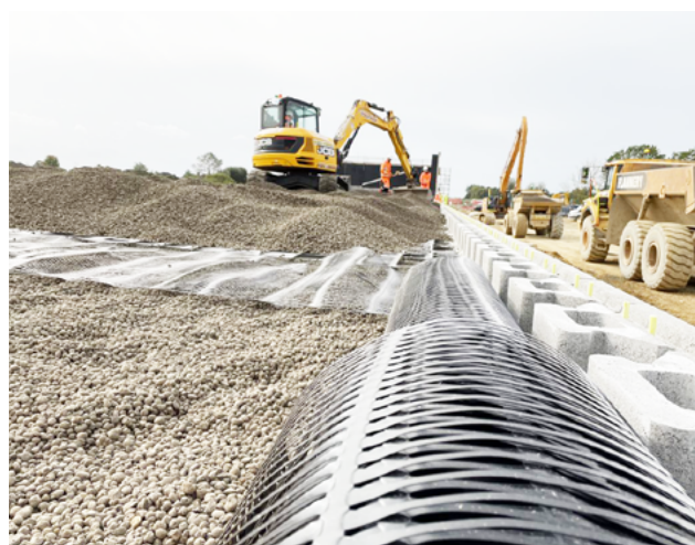
Innovation möter infrastruktur: synergin mellan Leca Lättklinker och geonät från Tensar Grid System i Spalding.
