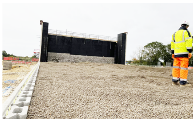
Användningen av Leca Lättklinker i områden med dåliga markförhållanden nära vattendrag har visat sig förbättra markstabiliteten.
