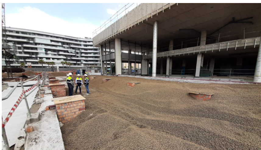
I Arlita-fyllnaden finns även dräneringsrör som förhindrar ansamling av vatten och potentiell överbelastning.
