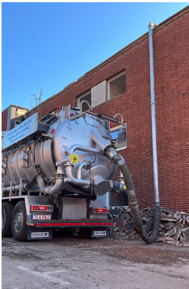
En sugbil ställdes enkelt upp nedanför byggnaden.
