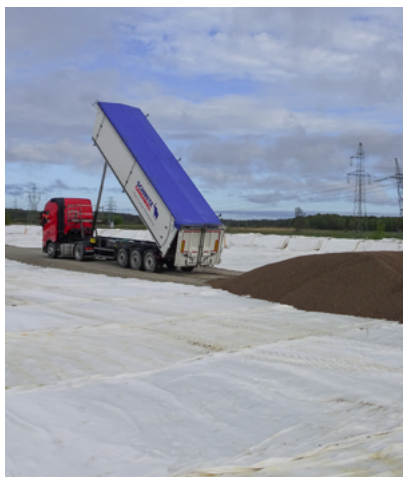
Det första arbetet tvingades man avbryta på grund av de komplicerade hydrogeologiska förhållandena som kraftigt försvårade genomförandet.
