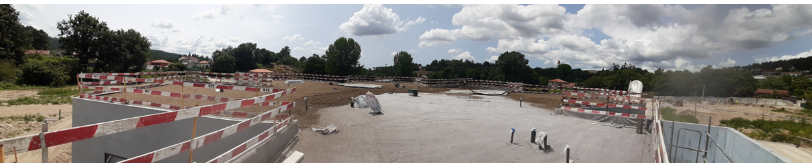
Cirka 250 m 3 pumpades ut direkt på byggnadens tak.
